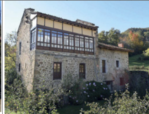
Fachada norte (general)
