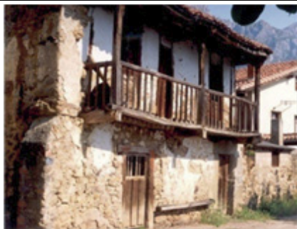
Alzado sudeste (antes de la intervención)
