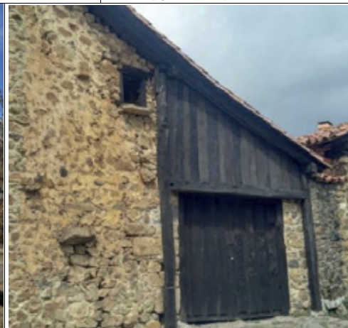
Detalle en fachada este
