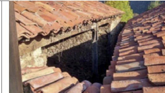
Espacio intersticial entre esta edificación y la colindante al sur
