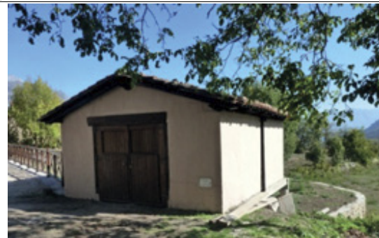
Fachada oeste y sur
