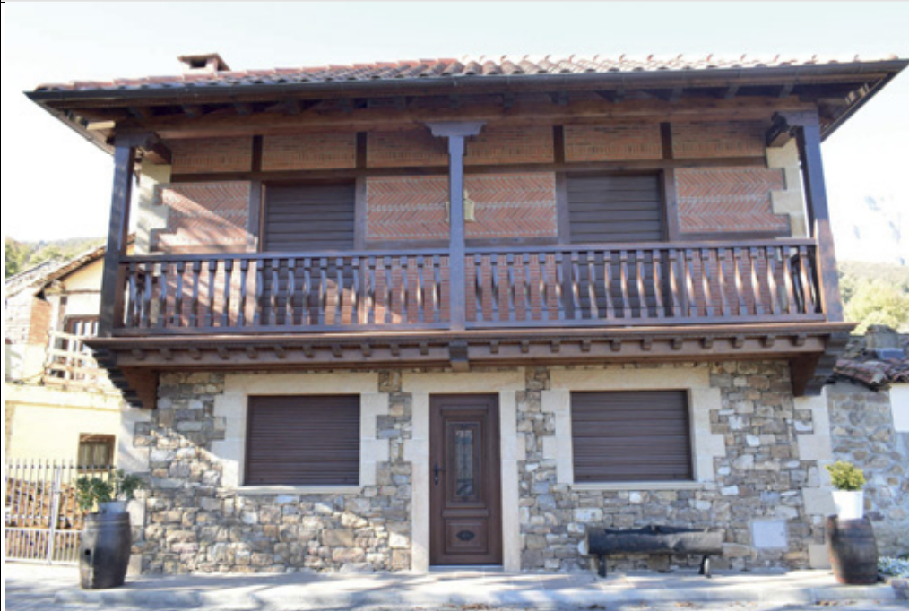
Fachada este (principal)
