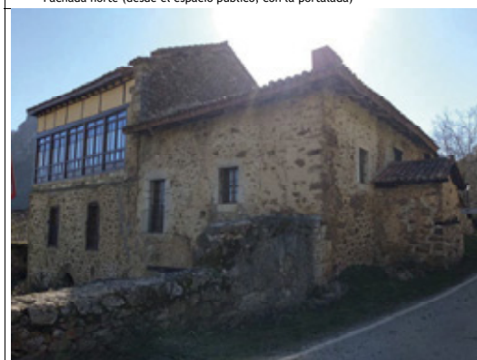
Vista general fachadas norte y oeste
