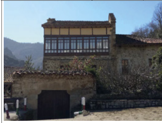
Fachada norte (desde el espacio público, con la portalada)
