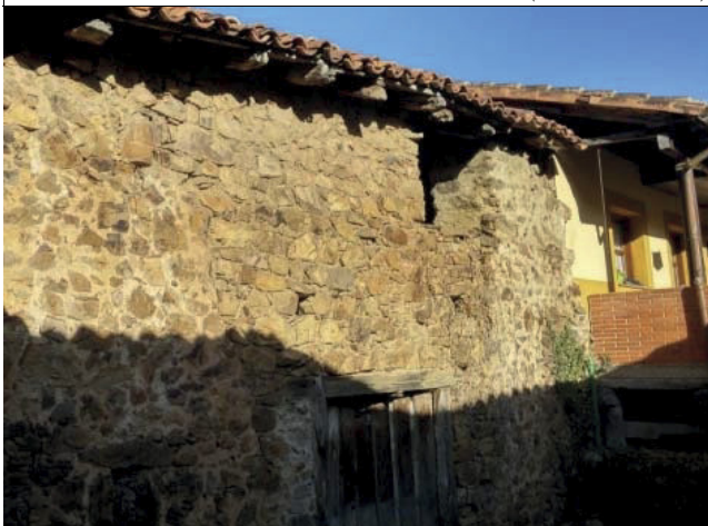
Fachada sur (a parcela interior)
