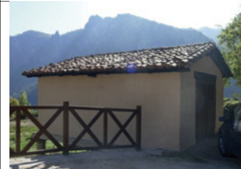
Fachada norte y oeste
