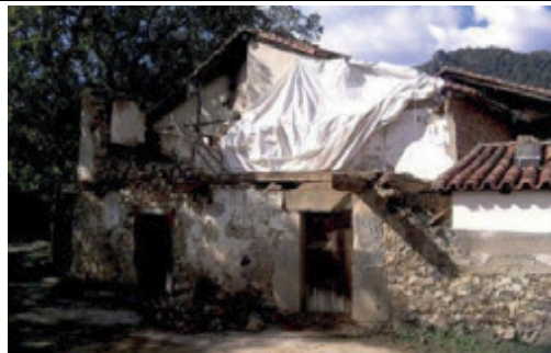
Alzado nordeste (antes de la intervención, parcialmente demolida)
